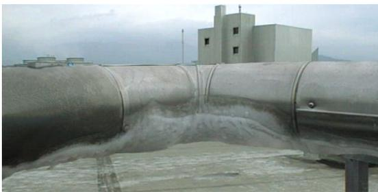
Ursache dieser Kondensationserscheinungen sind die Temperaturunterschiede zwischen Leitungsoberfläche und ihrer Umgebung. Die umgebende Luft enthält in Produktionshallen bis zu 85% Luftfeuchtigkeit. Diese Feuchtigkeit sammelt sich in Form von Wassertropfen an der Oberfläche der Leitung. Das entsteht dadurch, dass warme Luft mehr Flüssigkeit binden kann als kalte Luft. Trifft nun die warme Luft der Umgebung auf die deutlich kältere Temperatur an der Leitungsoberfläche kühlt die Luft rapide ab
